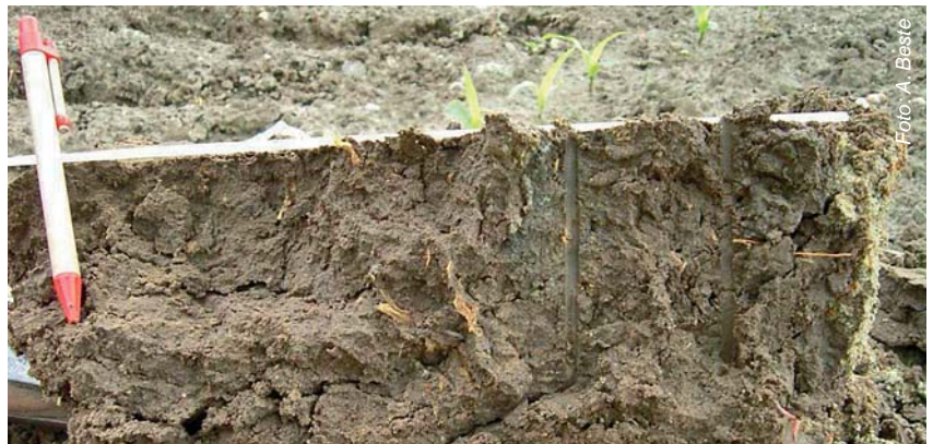
Verdichteter Lehm Boden
